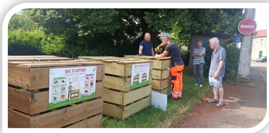
Installation du site de compostage partagé – Commune de ARRAY-ET-HAN – juin 2024
